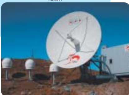
昭和基地管理棟より500m離れた岩盤上に設置された衛星通信用アンテナ
