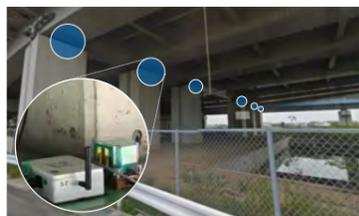
加速度センサと無線機の設置により、災害発生時などの橋桁や橋脚の異常を遠隔地からリアルタイムに検知可能
