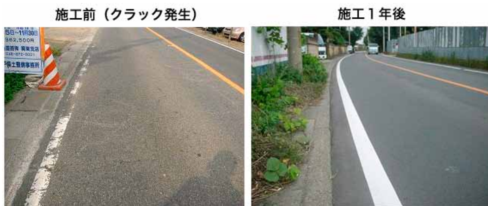
道路舗装面の施工前と施工1年後の比較
