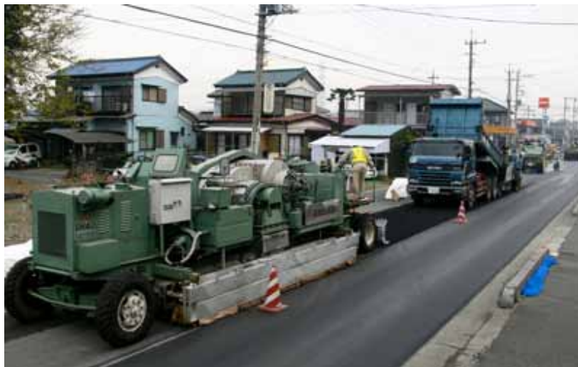
ヒートスティック工法の工事現場
