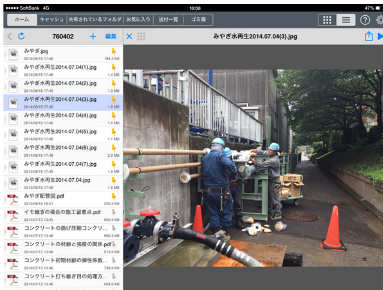
iPadで撮影した現場写真や図面データなどは、すべてクラウドソリューションのPrimeDriveに保存。高度なセキュリティを維持しつつ、共有設定などの管理がわかりやすいのが特徴だ
