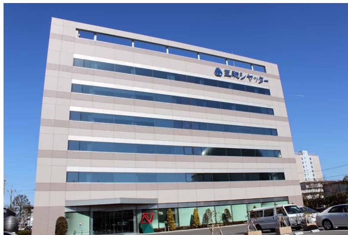
三和シャッター工業 東京本社
