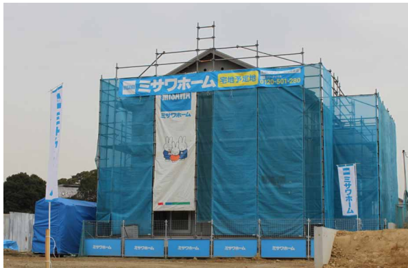
ミサワホーム九州が建設中の分譲住宅
