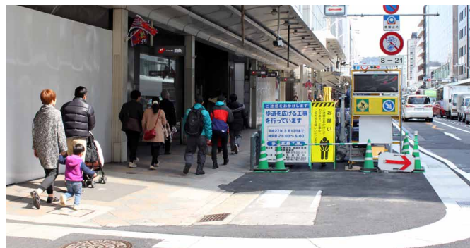
歩道拡幅工事が進められている四条通。車道を1車線つぶして歩道化し、歩行者に快適な空間を提供することで地域の活性化を狙っている
