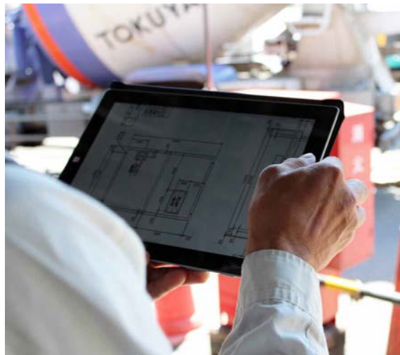
電気施工図面を Surface 3 から CAD ソフトを操作して現場で確認
